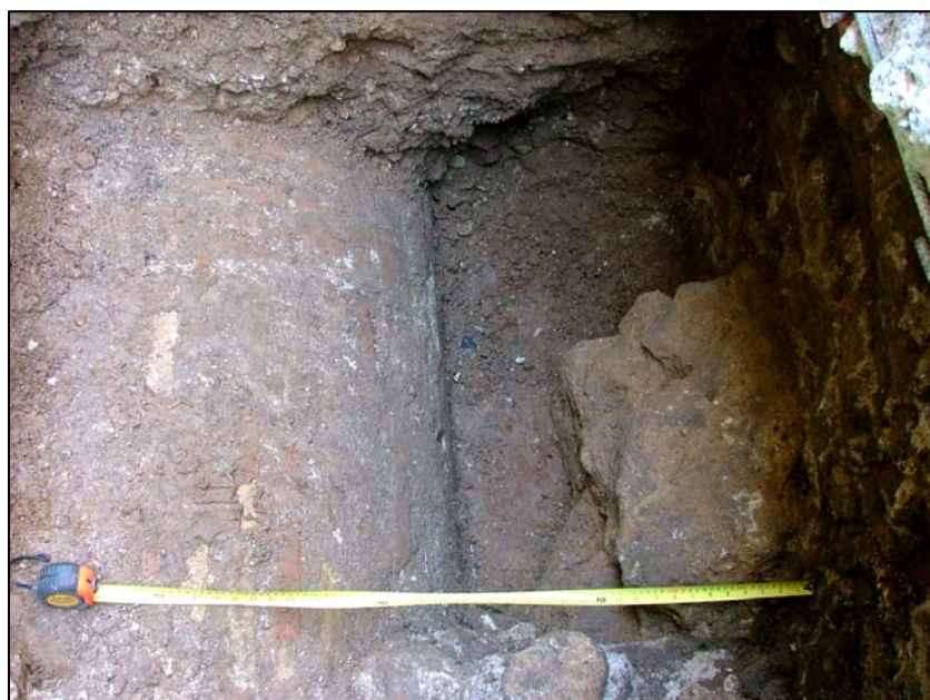
Foto 2. Cala 3. Vista del col·lector antic (UE 004) amb el mur pantalla del col·lector modern (UE 005)
