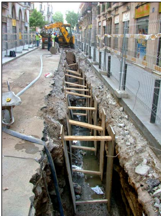
Foto 5. Procés d'obertura de la rasa del carrer de la Princesa
